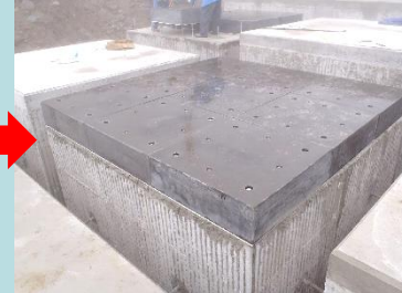
ESCON保護ブロック(耐磨耗パネル)
