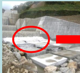
ESCON保護ブロック(耐磨耗パネル)
