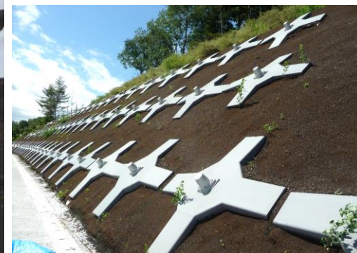
ESCON受圧板設置状況(近接)
