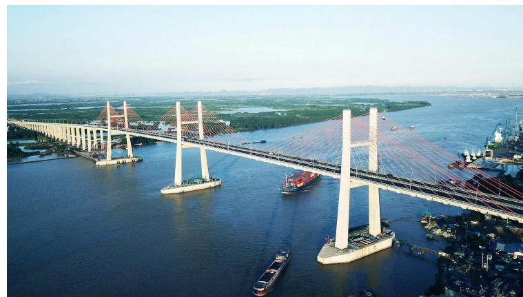
バクダン橋(ベトナム、ハロン湾ハイフォン) 全長5km、5径間連続PC斜張橋、スパン240m、幅員6車線27m 2018年9月1日完成、総工事費270億円 日越国交樹立45周年記念 (株)エスイー、(株)アンジェロセックによる 提案・設計 BOT投資プロジェクト
