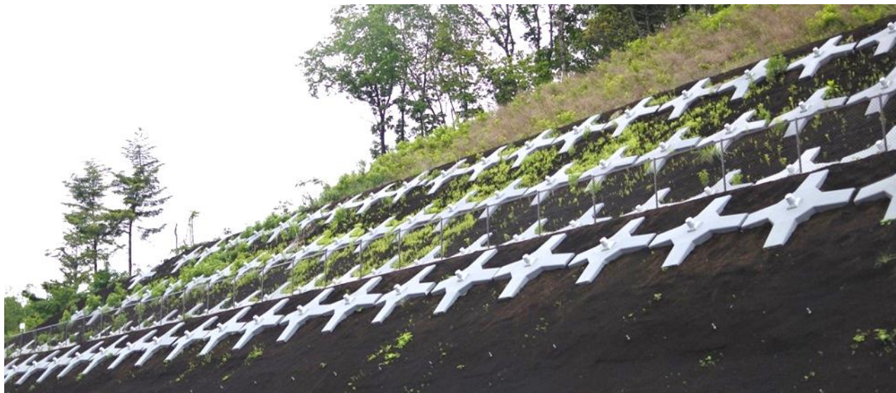
ESCON受圧板設置状況(植生機材吹付け後)
