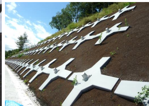
ESCON受圧板設置状況(近接)
