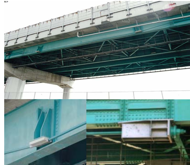
外ケーブルを使用した 高速道路橋の補強
