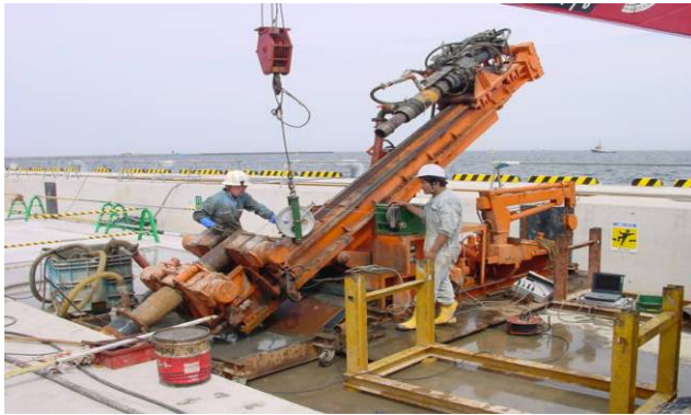
アンカーでの港湾耐震補強
