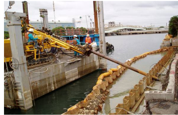
アンカーでの港湾耐震補強
