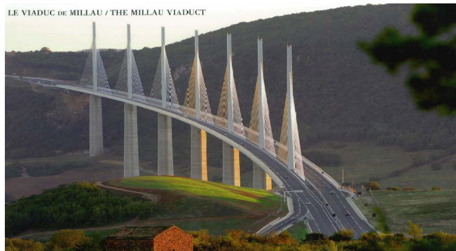
フランスのミヨー橋 (PPP成功事例)
