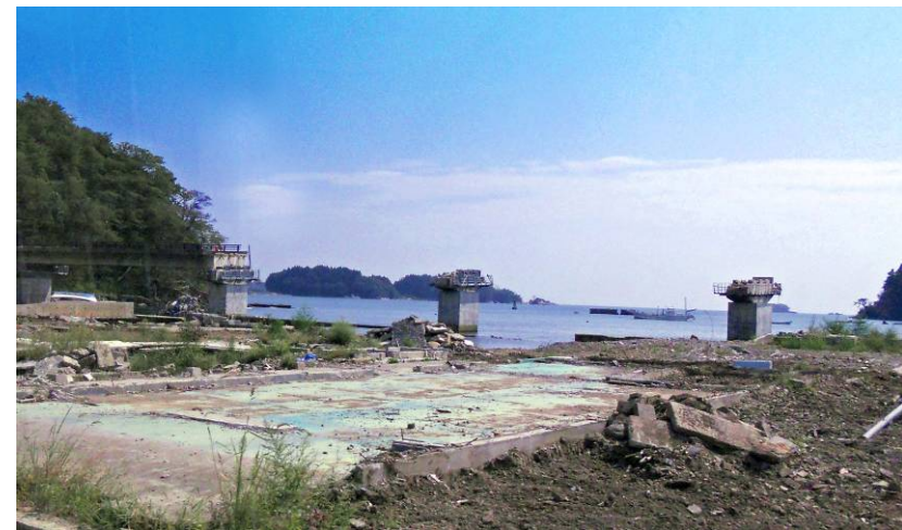
津波で崩壊した歌津大橋(宮城県南三陸町)
