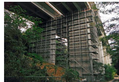
山口県下関市「小倉池橋」
