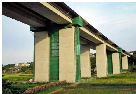
長崎県大村市「大上戸川橋」
