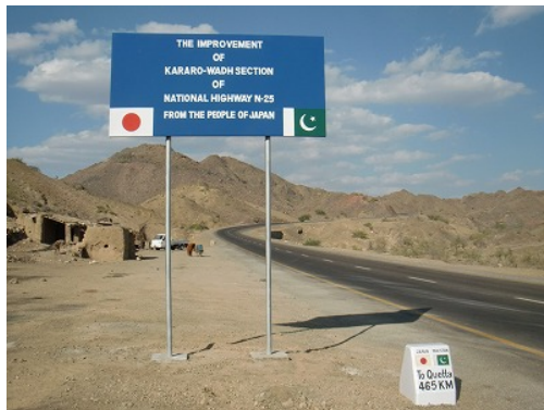
パキスタン 『国道25号線改修計画施工監理』
