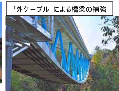
「外ケーブル」による橋梁の補強 京都府船井郡「広野大橋」
