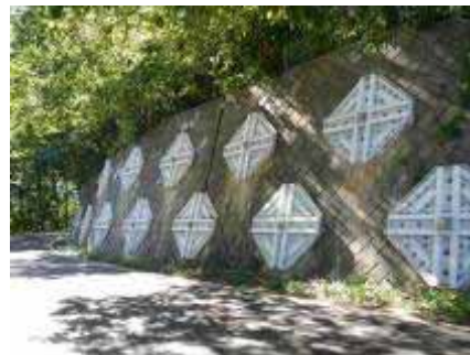
KIT受圧板とダブルアンカー
