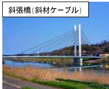
斜張橋(斜材ケーブル) 秋田県由利本荘市 新「由利橋」
