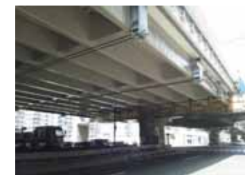
■首都高の補修・補強 (外ケーブル、落橋防止装置)
