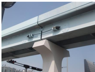
■橋桁の落下を防ぐ落橋防止装置
