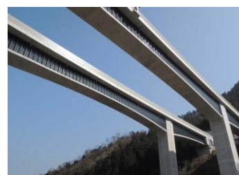
■PC用ケーブル(FUT)および落橋防止装置を採用
