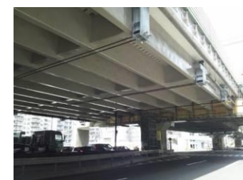
■首都高の補修・補強 (外ケーブル、SEリミッター、落橋防止装置)
