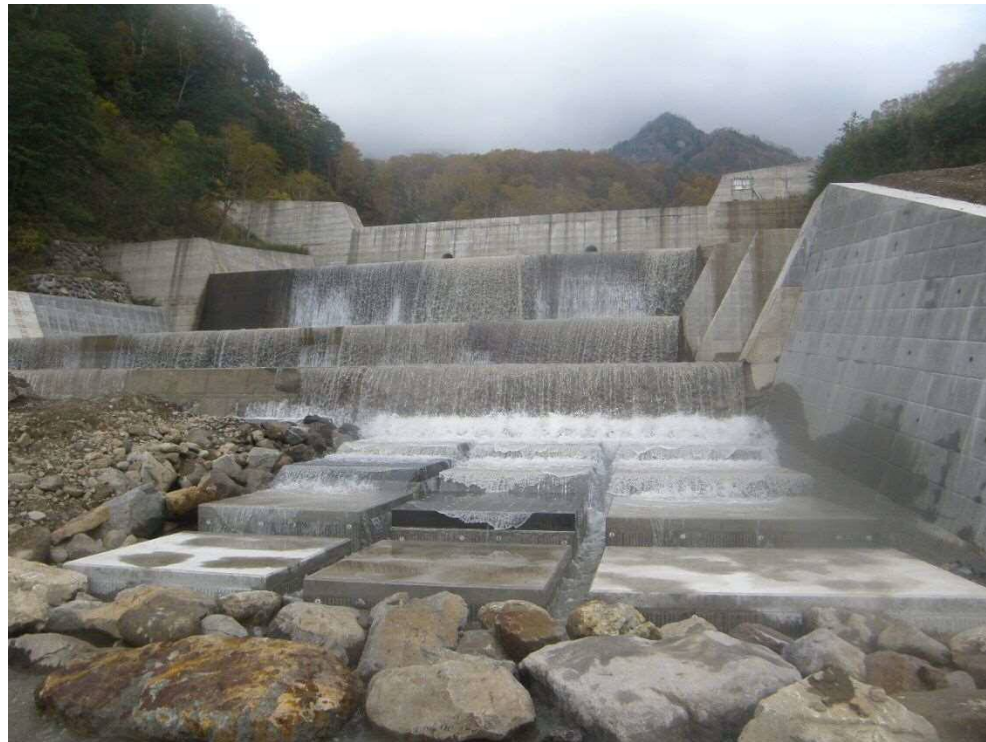
砂防えん堤(試験施工現場)
