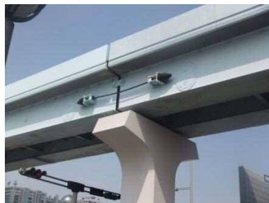
■橋桁の落下を防ぐ落橋防止装置
