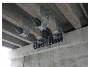
横変位拘束構造・水平力分担構造 (SEリミッター)と落橋防止装置 (F-TD型)による耐震補強工
