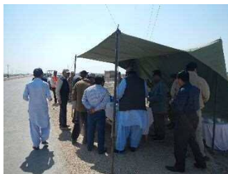
現地施工指導
