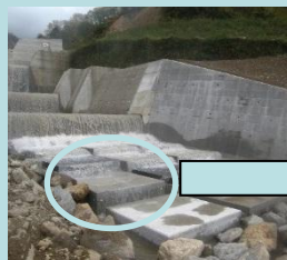
ESCON保護ブロック(耐磨耗パネル)
