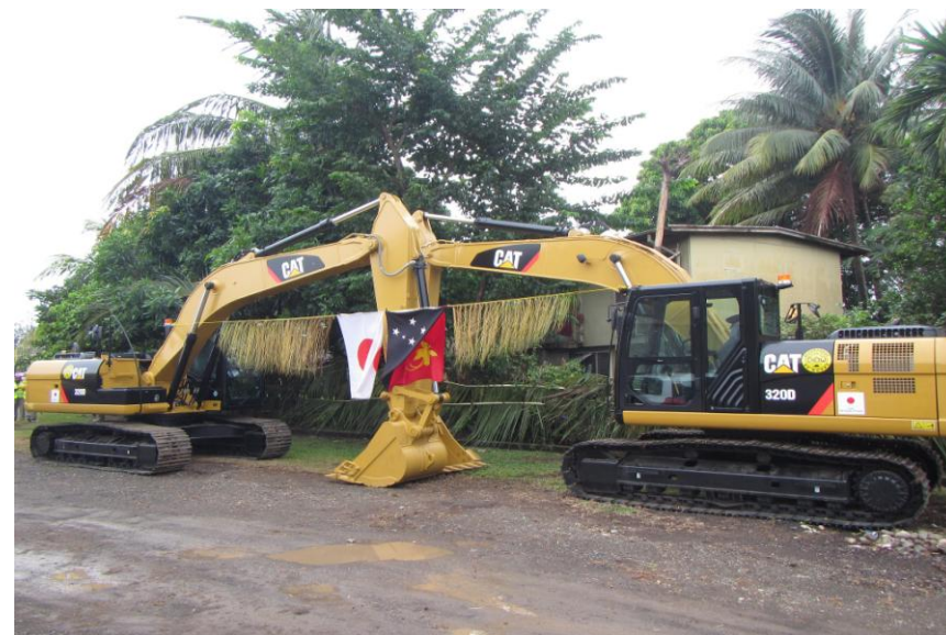
＜パプアニューギニア 道路整備プロジェクト＞
