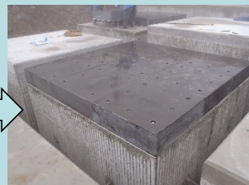
ESCON保護ブロック(耐磨耗パネル)
