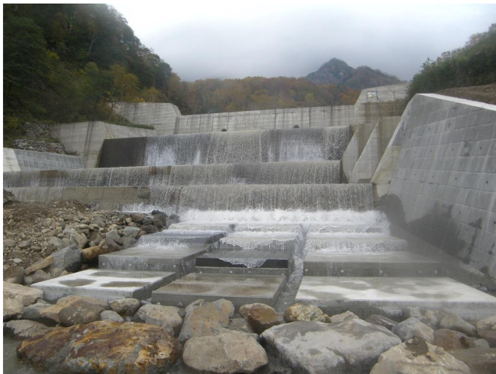
砂防えん堤(試験施工現場)
