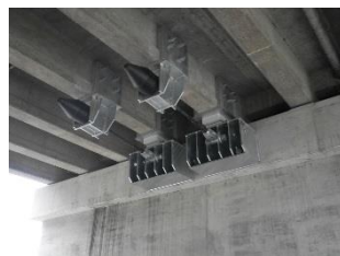
横変位拘束構造・水平力分担構造 (SEリミッター)と落橋防止装置 (FD型)による耐震補強工
