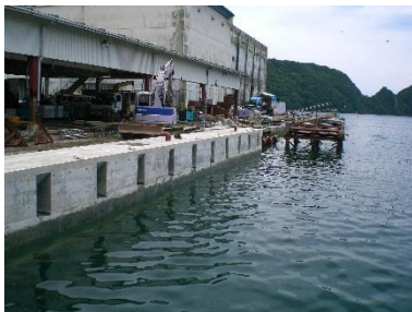
■アンカーによる港湾の岸壁補強
