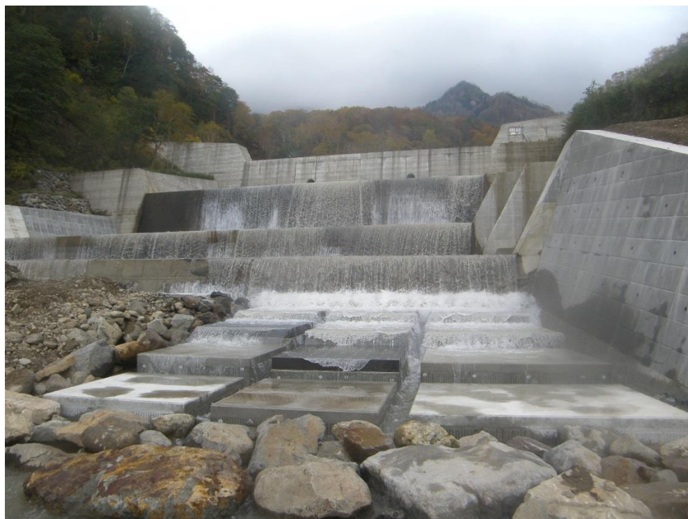
砂防えん堤(試験施工現場)
