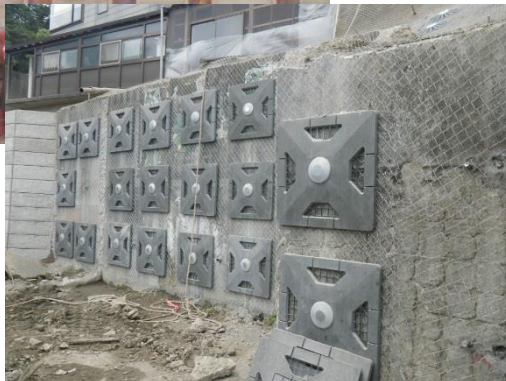
兼六園法面納入状況
