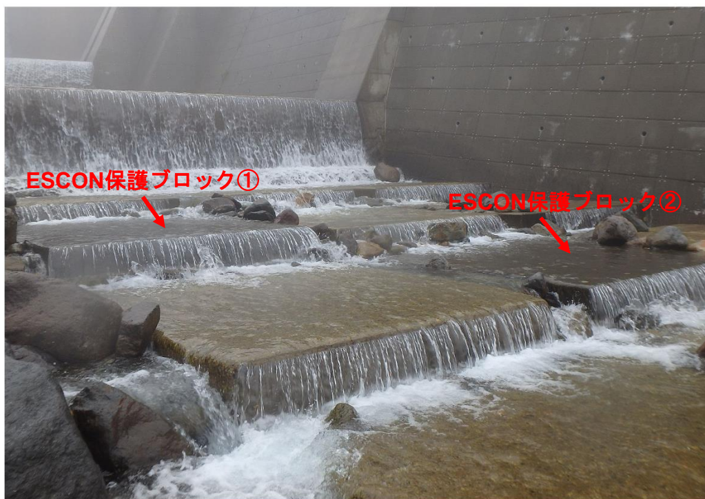
砂防えん堤(試験施工現場)
