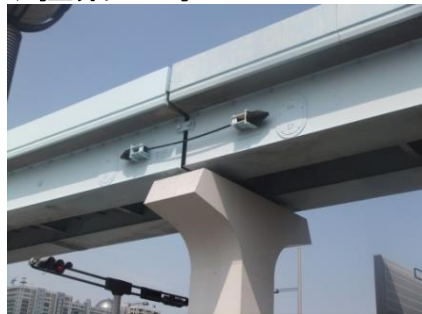
橋桁の落下を防ぐ落橋防止装置
