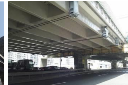
首都高の補修・補強(外ケーブル、SEリミッター、落橋防止装置)
