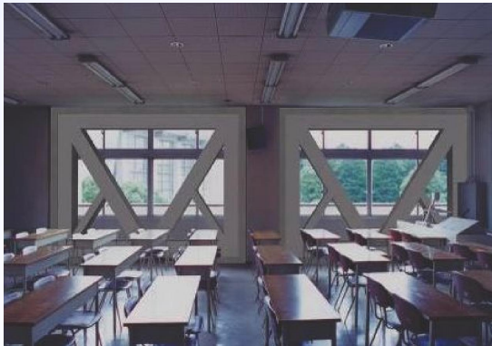
在来構法 (鉄骨ブレース)
