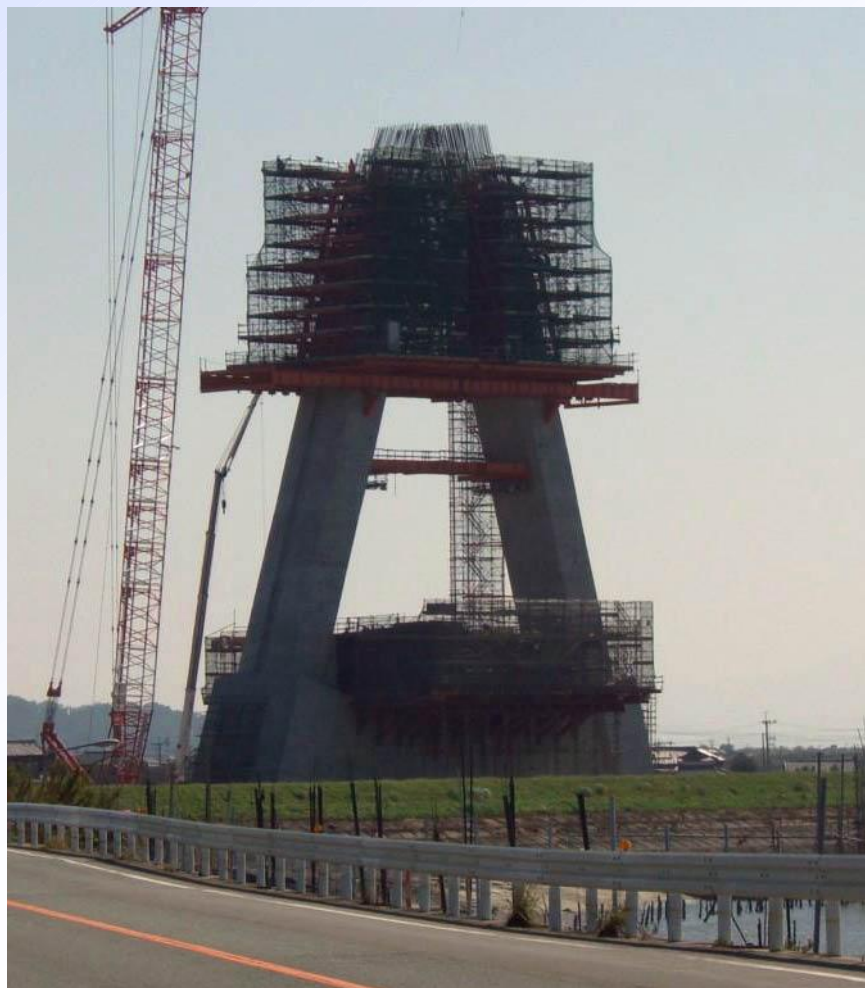
主塔の建設状況
