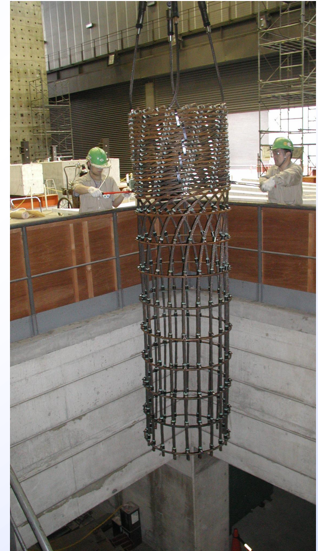
建込み実験の様子
