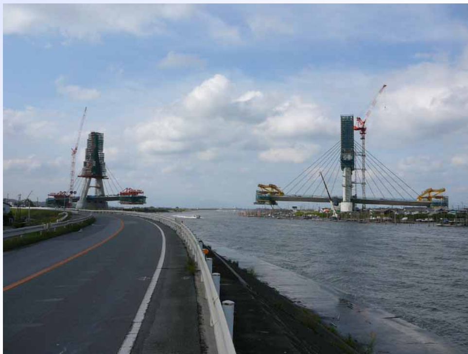
(写真左) 斜材架設の様子
