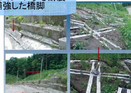
くさび定着アンカーの地震による被害
