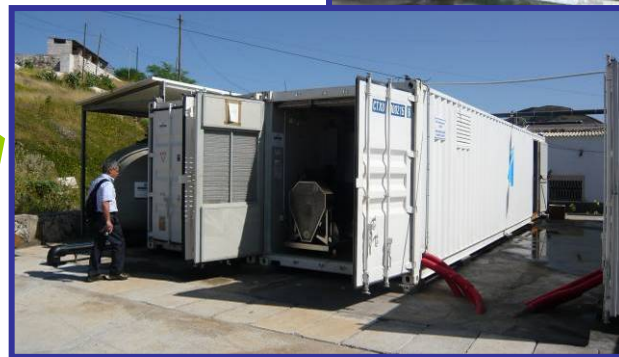
プライア市(首都)近郊の 最新の海水淡水化設備 逆浸透(RO)膜式
