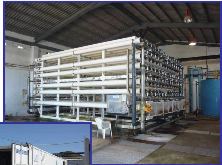
プライア市(首都)近郊の 最新の海水淡水化設備 逆浸透(RO)膜式
