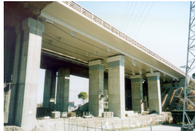
小柳津高架橋(静岡県)
