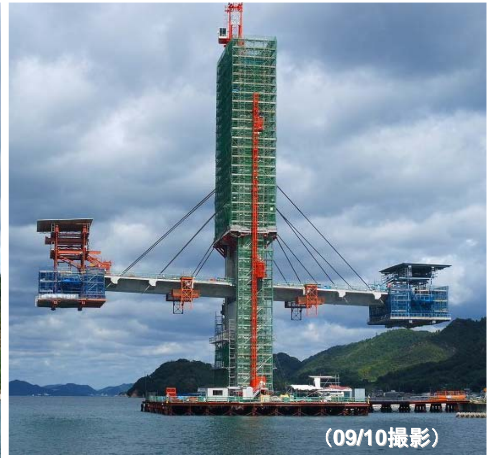
3径間連続鋼・コンクリート複合斜張橋( 515m = 100m+315m+100m)
