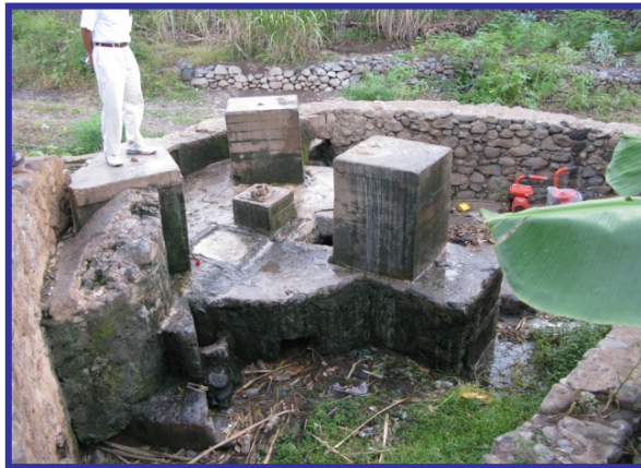
老朽化し不衛生な既存の井戸施設
