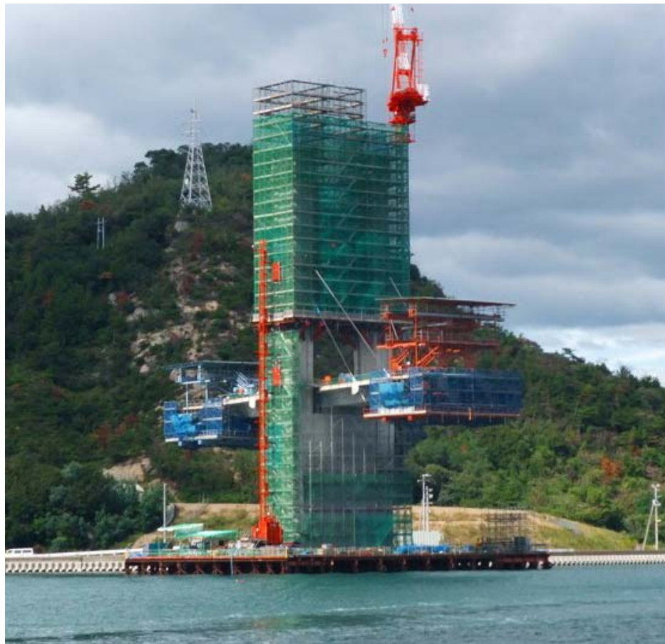
3径間連続鋼・コンクリート複合斜張橋( 515m = 100m+315m+100m)
