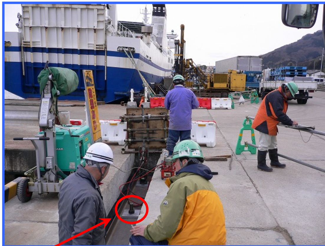
当社アンカー：護岸工事風景
