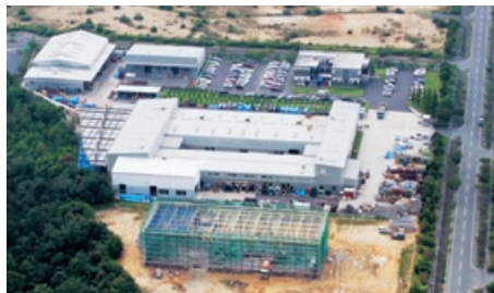
工場建物建設中の様子
