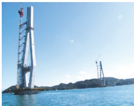
鷹島肥前大橋（主塔）
