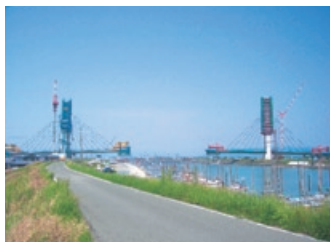
矢部川橋斜材架設の様子
