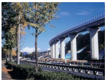
名古屋・東部丘陵線の高架橋
