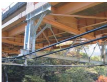
特許出願したジャッキ使用の施工例
